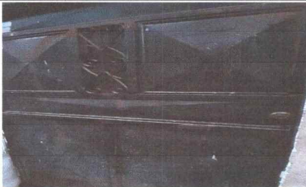
Foto 3: Sustitución de puerta
