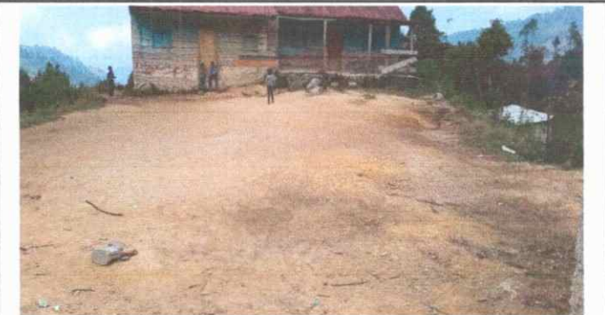
Foto 6: Sustitución de torta
