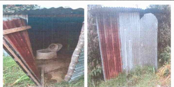
Foto 4: Sustitución de baños
