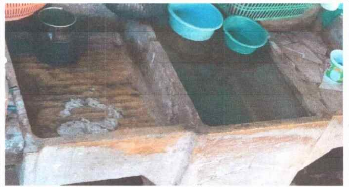
Foto 2: Sustitución de pilas de dos lavaderos
